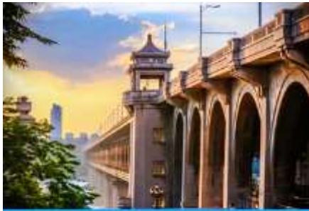
สะพานข้ามแม่น้ำหวู่ฮั่น
